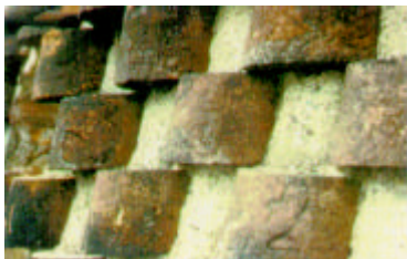
I mattoni e la malta della cuspide prima della pulitura
