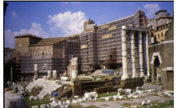
Le pareti in tufo interessate dal restauro
