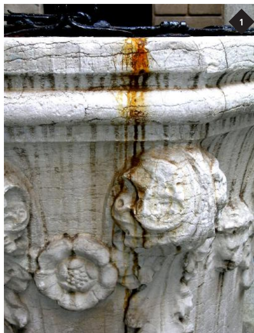
◆ FIGURA 1 MACCHIA ACCIDENTALE DI RUGGINE SU UNA VERA DA POZZO IN CALCARE BIANCO ("PIETRA D'ISTRIA", VENEZIA).
